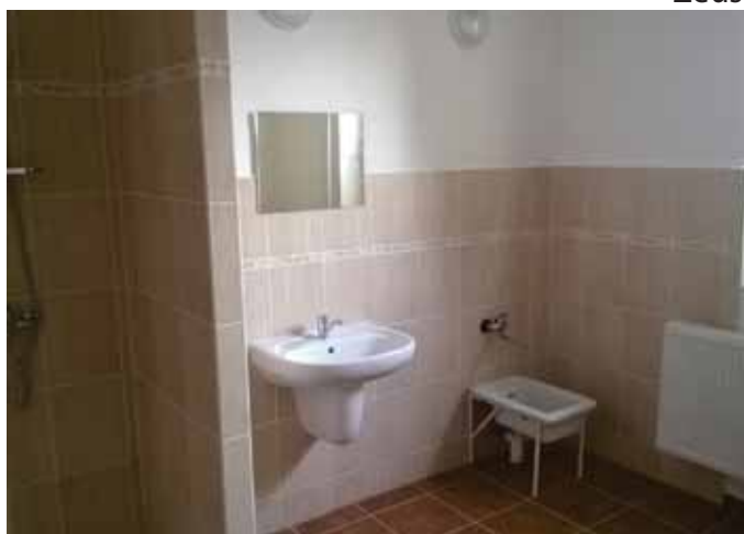
Rekonstrukce sociálních prostor
